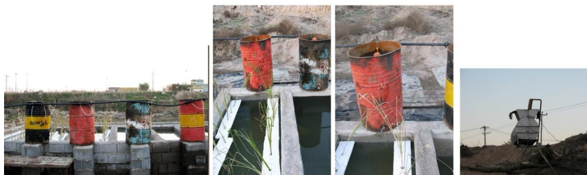
شکل (۱): نمایی از سامانه‌های تالاب مصنوعی احداث شده در محوطه کارخانه کشت و صنعت نیشکر کارون
